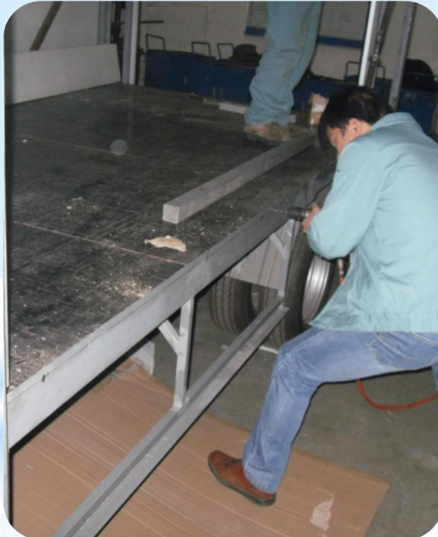
\* 将白密封胶抹在Holypan与车厢架的连接处，使二者连接更加牢固。
